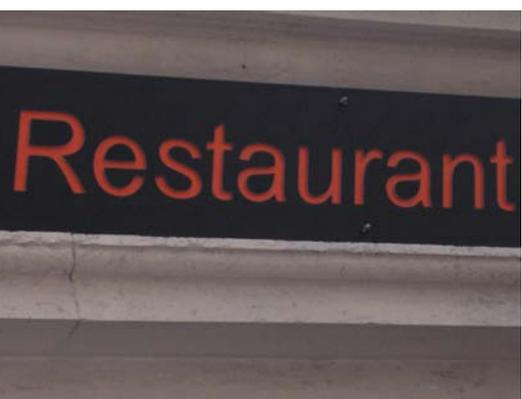
Detail : Trägerplatte aus Metall mit ausgeschnittenem, farbig hinterlegtem und nachts beleuchtetem Schriftzug.
