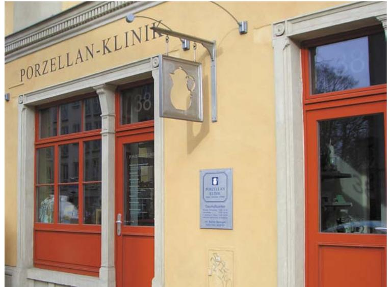
Bei der Höhe der Befestigung der Tragkonstruktion gilt: Oberkante Ausleger = Unterkante Erdgeschossgesims, bzw. Oberkante Erdgeschossfenster. Das Symbol der Kanne steht hier stellvertretend für das Töpferhandwerk.
