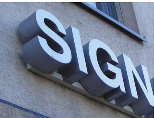
Detail: Hinterleuchteter Schriftzug, bestehend aus vor die Fassade gesetzte Einzelbuchstaben.
